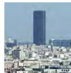
La Tour Montparnasse
