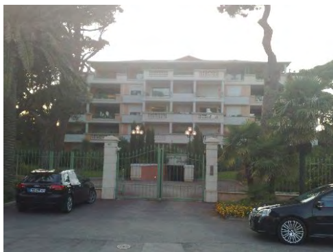
Vue du bâtiment derrière la résidence
