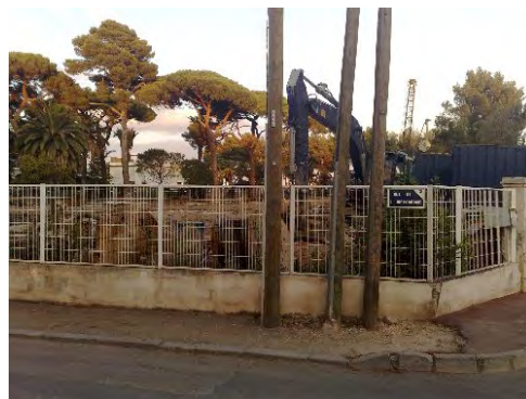
Vue du terrain depuis la rue de l'hippodrome
