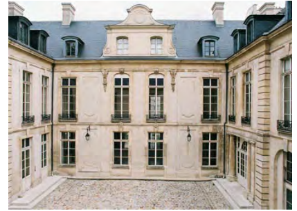
Façade intérieure sur cour Hôtel de Hesse
