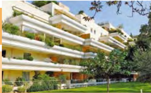
Résidence Le Pavillon du Parc - Montpellier
