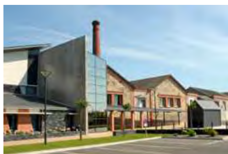
Les Ardoisières - Trélazé
