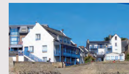
Résidence Les Bains - Trégastel (22)
