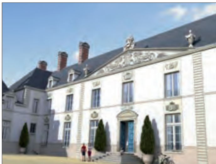
Château de la Seilleraye à Nantes/Carquefou (44) En cours de réhabilitation
