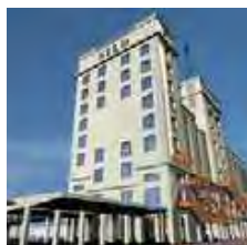
Le Silo d'Arenc
