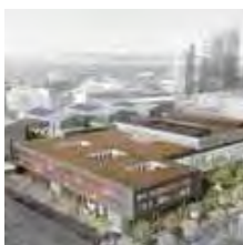
Le futur hôpital Euroméditerranée Ambroise Paré - Paul Desbief
