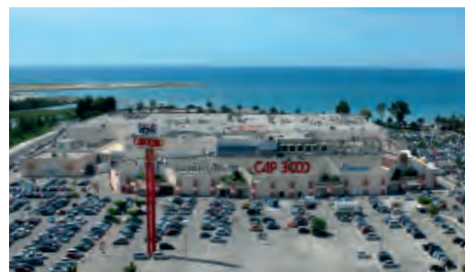
Cap 3000, l'un des plus grands centres commerciaux de France.
